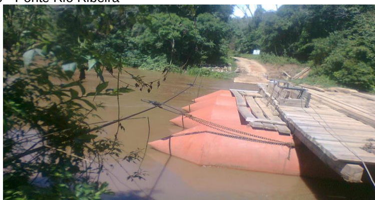
Figura 10 - Ponte Rio Ribeira
