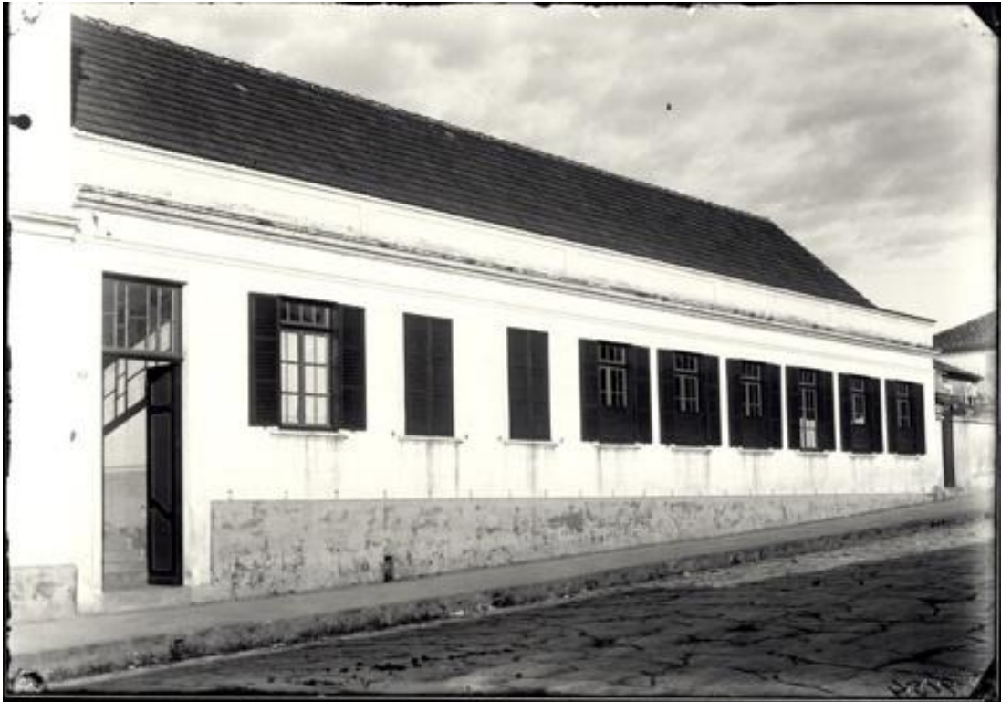
Figura 3 - Imagem da fachada lateral do Ginásio São José.
