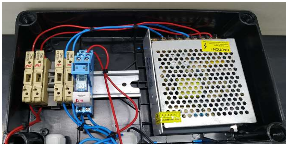
Figura 4: montagem do painel de controle.
